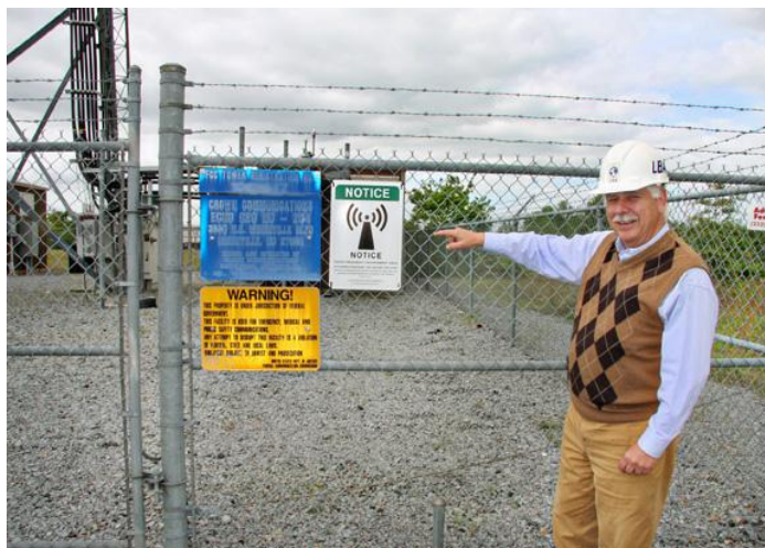
شکل ۵۷- نصب علائم هشداردهنده در محل‌های مورد نیاز به‌عنوان اقدام مدیریتی
